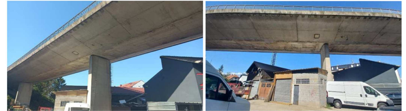
Vus des bâtiments sous ouvrage – travées P1 à P3
