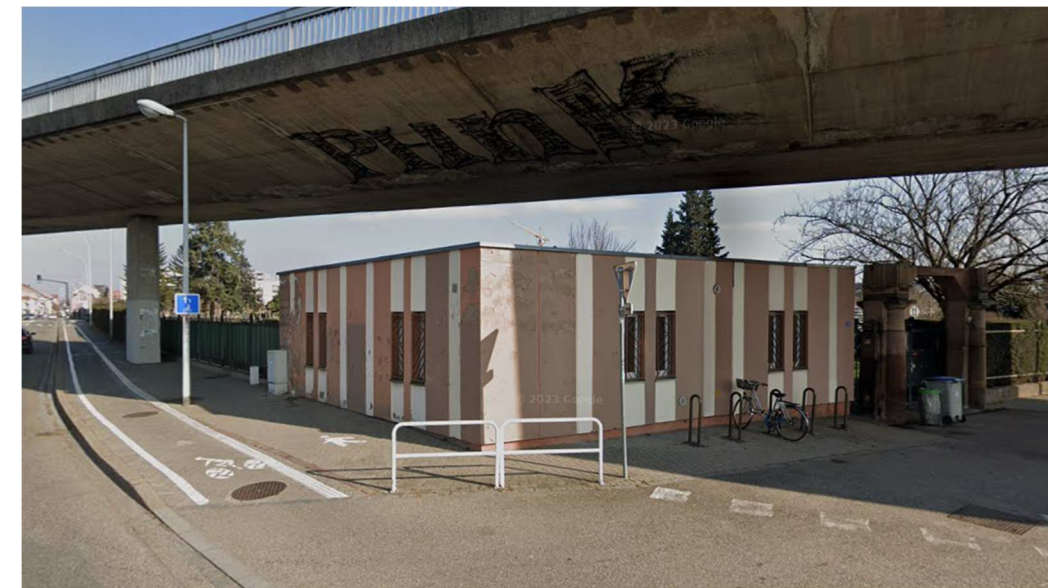
Figure 5 : Photo Google du local existant et du viaduc le surplombant
